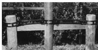
2 attaches – longueur 810 mm + 4 pièces intermédiaires
